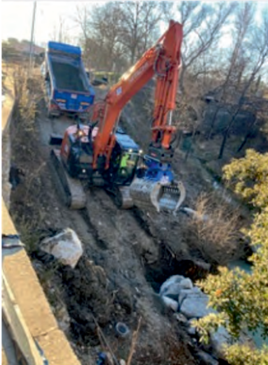
Mise en place des blocs en pierres du futur talus
