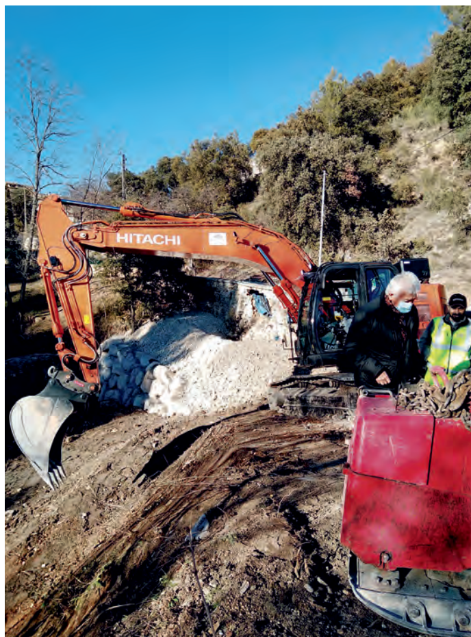
Réalisation du talus en remblai et compactage des couches successives de grave par compacteur télécommandé
