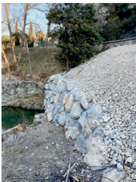
Mise en place des blocs en pierres du futur talus
