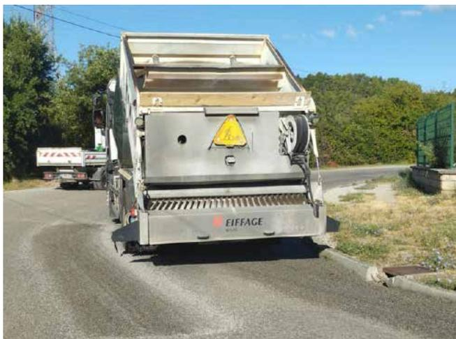
Accompagnée par l'entreprise professionnelle de la route EIFFAGE, **la commune a opté pour la technique de mise en œuvre des emplois partiels à l'émulsion par point à temps automatique (PATA) :**
